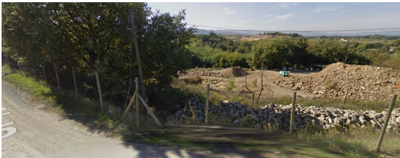
Vista dalla via Provinciale 16, ovest
