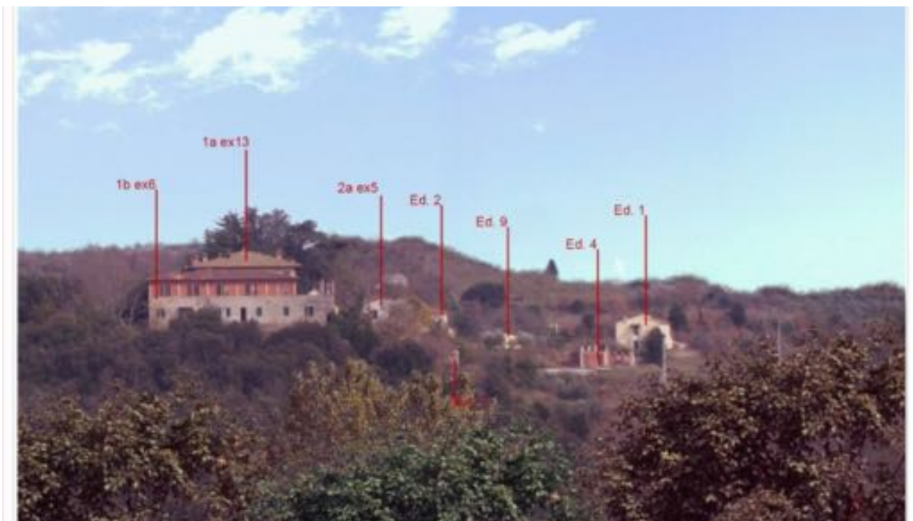
Vista da ovest, stato attuale
