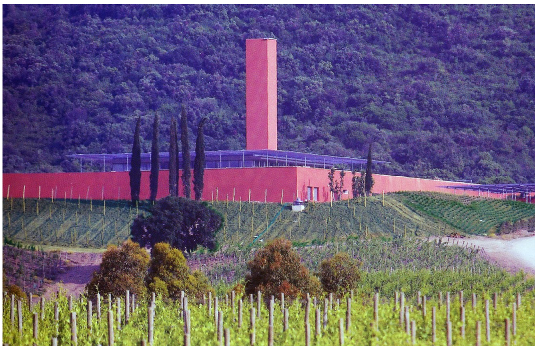
La cantina di Rocca di Frassinello nelle pendici collinari di Giuncarico
