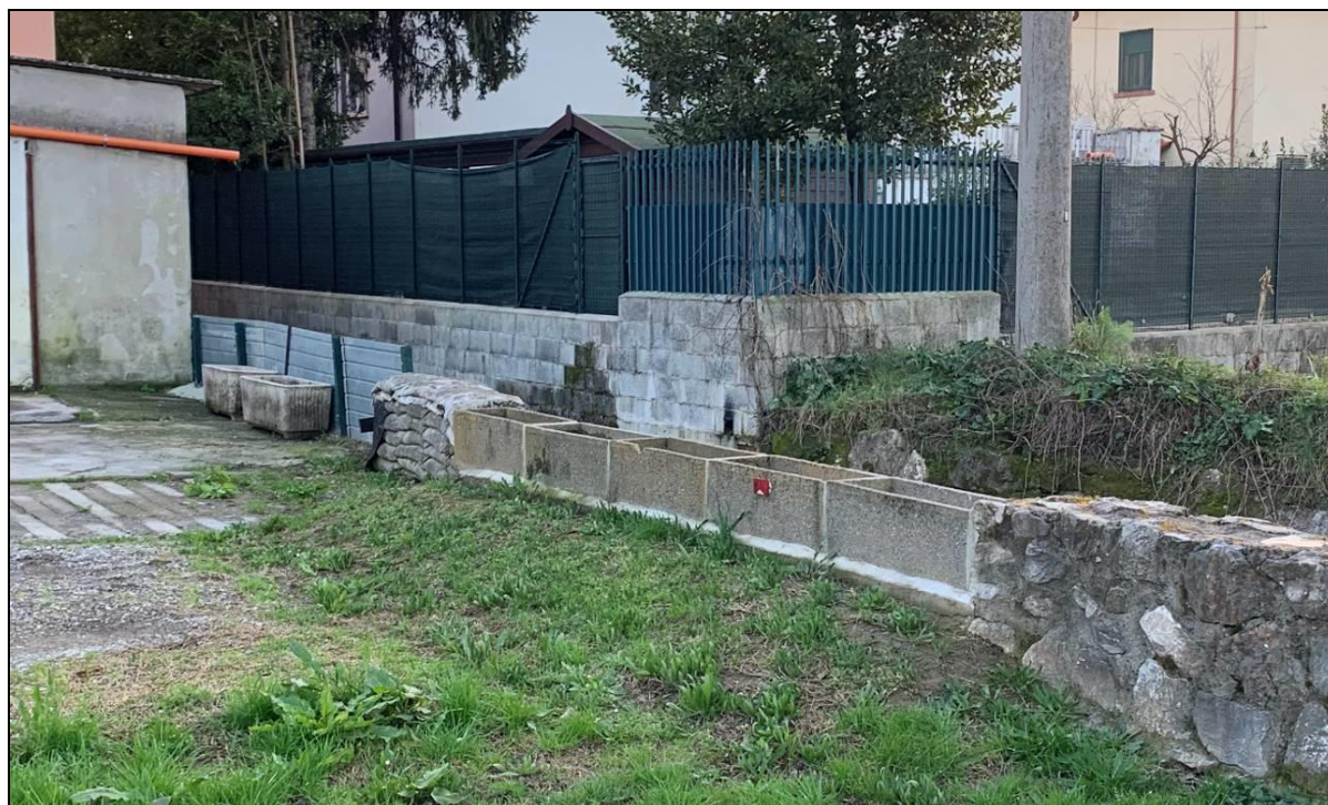
Figura 4.4 – «Opere di sponda» provvisionali poste nel tratto non sistemato del corso d'acqua.
