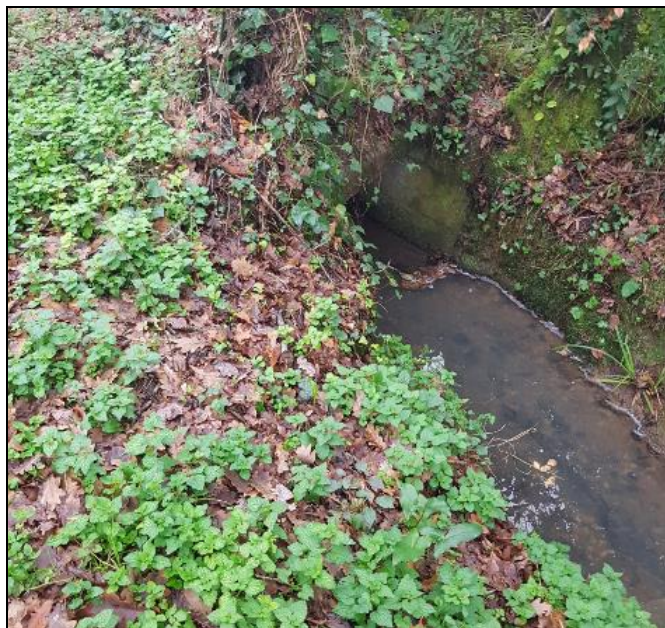
Figura 4.1 – Sbocco dell'attraversamento del tombamento.
