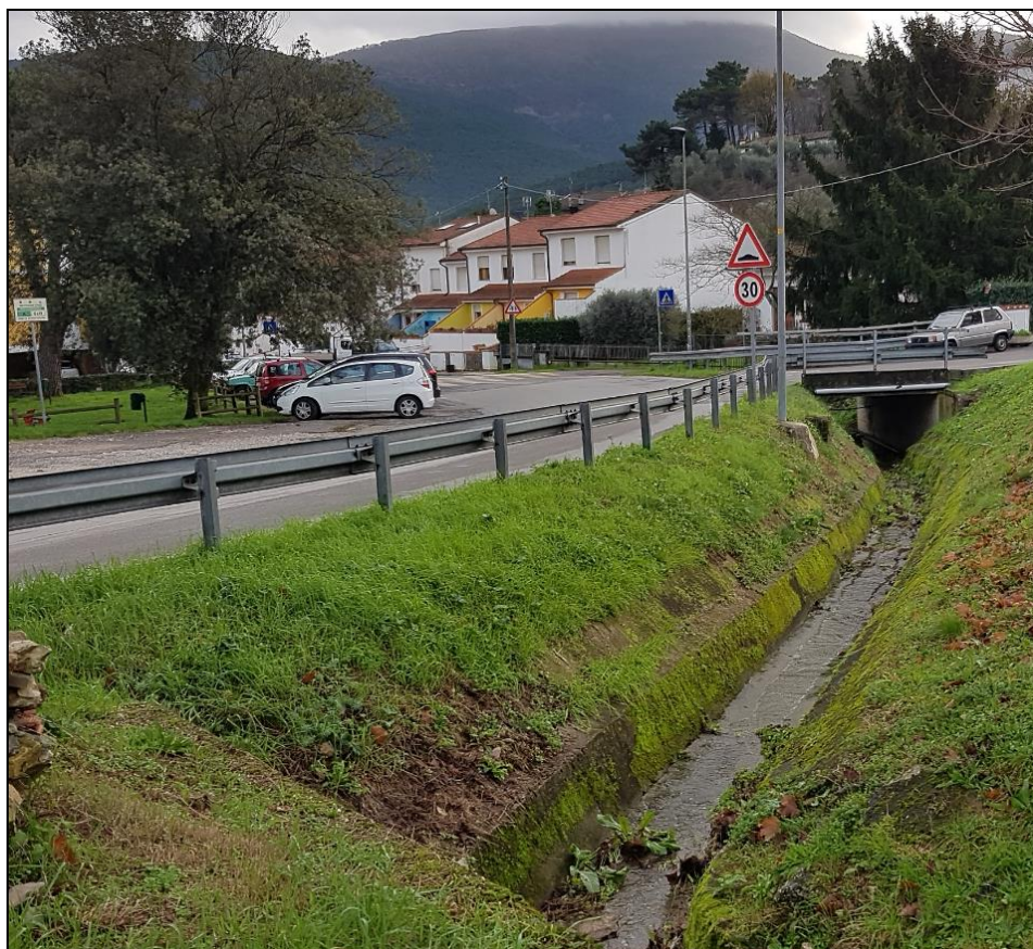
Figura 4.21 – Tombamento del Rio di Querceto. Si palesa che le dimensioni non sono tali da far immaginare la completa ostruzione dell'attraversamento e di conseguenza indurre alla valutazione delle reali capacità di deflusso mediante realizzazione di modello idraulico.
