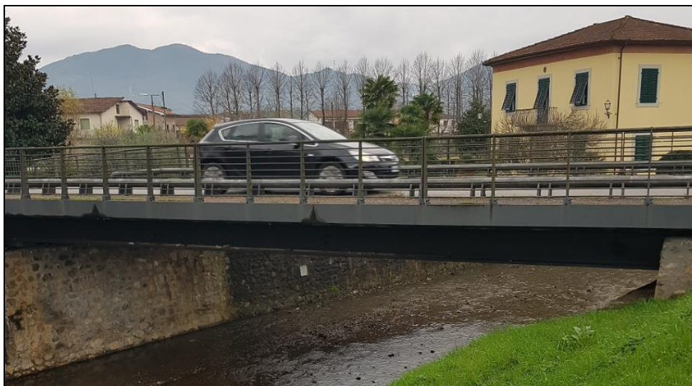
Figura 4.9 – Ponte ristrutturato su Via delle Nubache.
