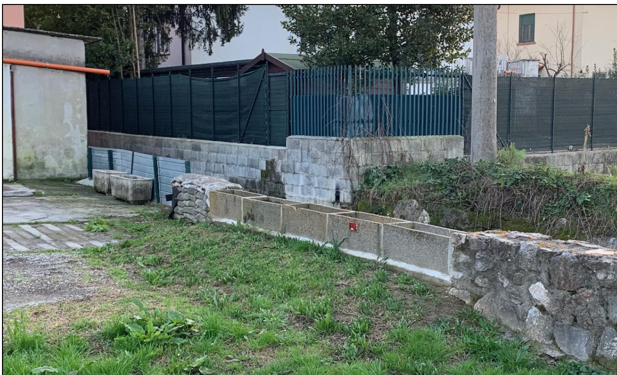
Figura 4.8 - «Opere di sponda» provvisorie poste nel tratto non sistemato del corso d'acqua.
