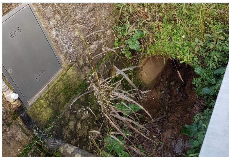
Figura 4.12 – Foto del tombamento riscontrato sul Canabbia Centro.
