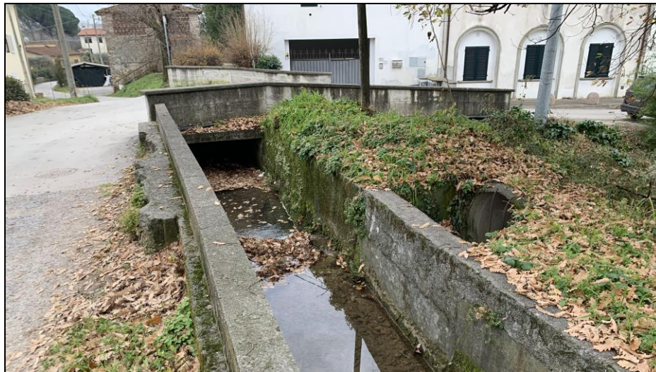
Figura 4.7 - Attraversamento di Via della Chiesa di Saltocchio del Rio Gatto.
