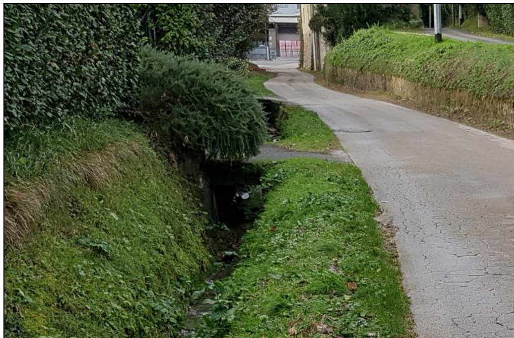
Figura 4.20 – Tombamenti ravvicinati sul Rio dei Frati. L'immagine mostra che eventuali intasamenti provocano la fuoriuscita di tutta la portata idrologica.
